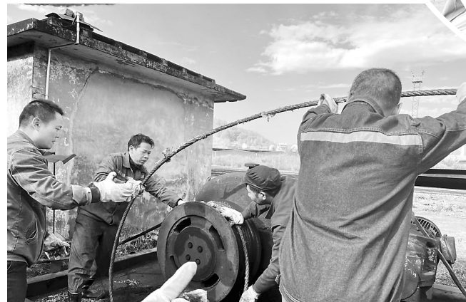
▲元旦期间,福建煤电公司坎市发运站利用发运空隙时间,组织相关人员更换站区铁路专用绞车牵引钢丝绳。(林玉梅 摄)
