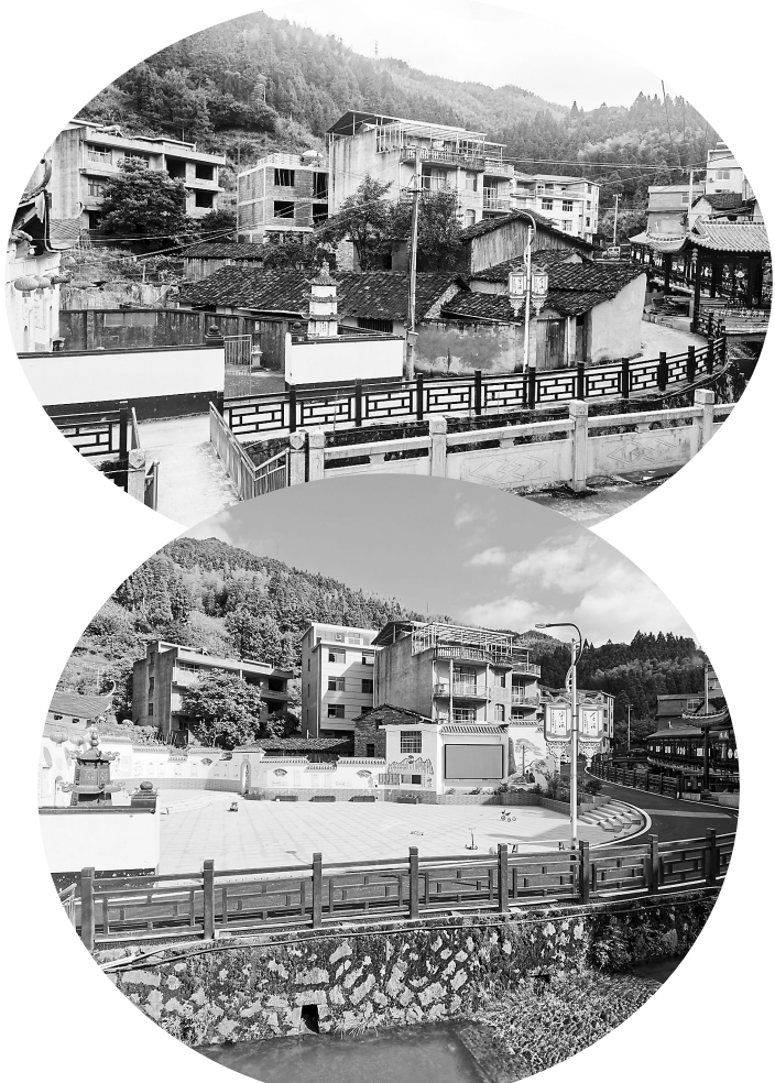
图为“能化园”广场改造前后 (陈泉兴 摄)
