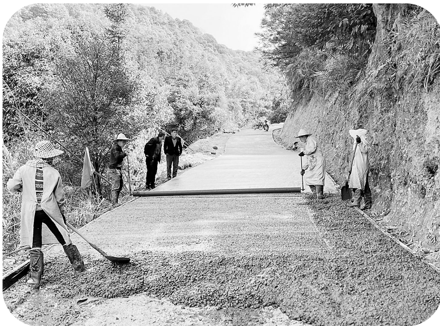
图为虎堂公路修建场景
