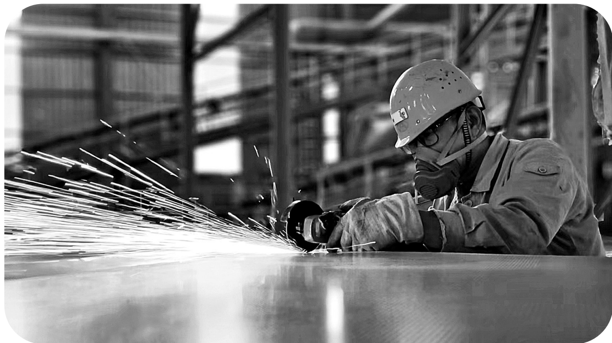
临近年底,福维公司钙化物项目进入全面试车达产和验收阶段。根据项目建设情况,该公司全力推进项目消缺和设施完善工作。图为该公司机械厂员工正在加紧制作安装振动筛隔音墙,以降低振动筛运行噪音问题。(曾治发 摄)
