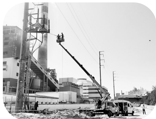
图为杆塔清洗现场
