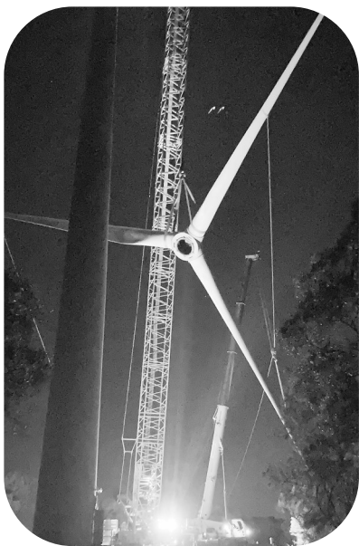
图为风机叶轮吊装现场
