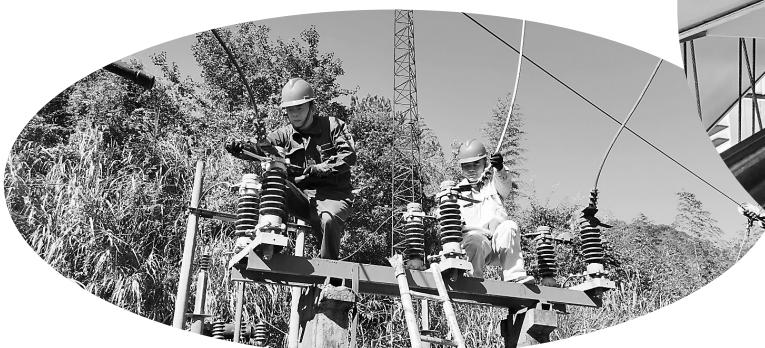
近日,福建煤电电力安装检修公司开展35kV铜锣坪变电站年度大检修工作。这次检修为期5个工作日,检修设备近百项。图为11月20日,该公司检修人员正在调整35kV户外操作机构灵活性。(王海峰 张建文 摄)
