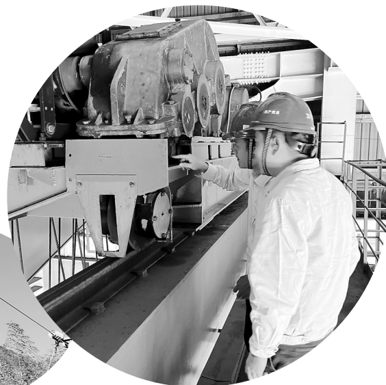
为保障起重设备安全、可靠运行,近日,鸿山热电公司开展汽机区域起重设备专项大检查。对检查中发现的问题及存在的隐患,要求维护单位做好记录并限期进行整改闭环。(陈铁辉 摄)
