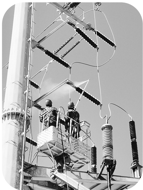
11月21日,晋南热电公司组织人员对110kV山源屿路#1杆塔电气设备进行带电清洗,为入冬后露天电气设备的安全运行做好充分准备。(周国利 摄)
