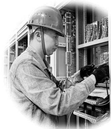
图为陈拓正在安装测控柜二次线路
