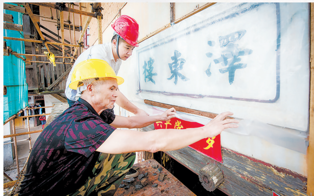
李园军(后)配合施工人员对“泽东楼”牌匾进行修缮。
