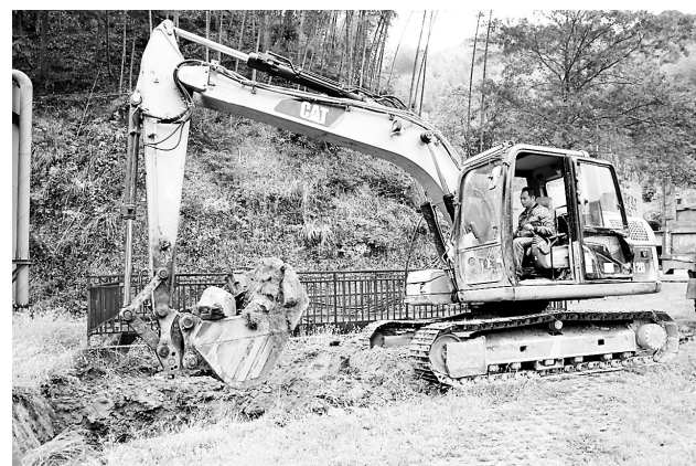
▲ 为了抓好环保工作，进一步完善矿井污水处理设施，10月12日，永安煤业公司池坪芦坑煤矿在污水处理站开工再建一个污水沉淀池。（陈思洲 摄）
