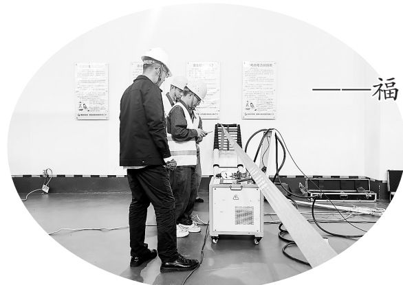
图为检修人员正在室内检修
