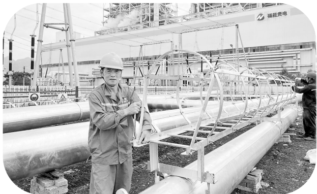
“双节”期间，福能贵电公司检修人员坚守岗位，正对500kV六盘水第三台主变扩建输变电工程做准备工作。（王加胜 摄）
