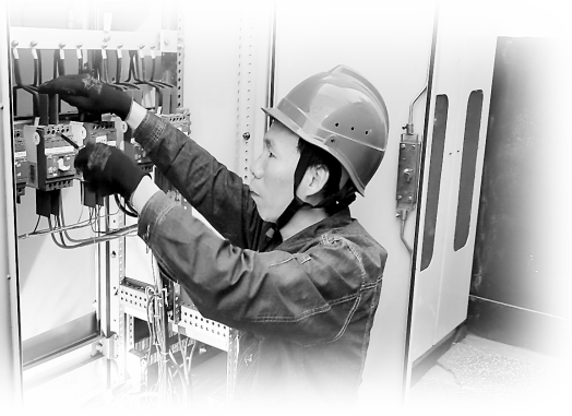
图为谢建玲正在检修空气开关
