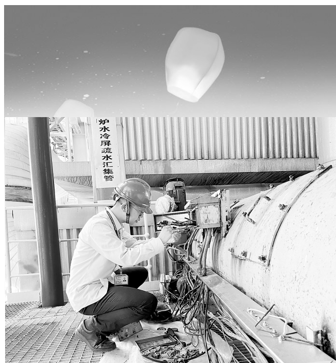
连日来,晋南热电公司设备维护部人员认真做好设备维护工作,确保全厂机组安全、稳定、可靠的运行。图为设备部热控专业工程师正在对给煤机进行检修维护。(叶岩 摄)
