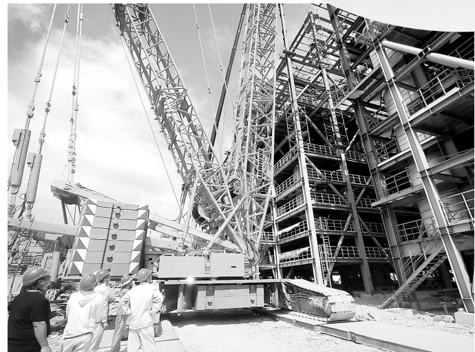
“双节”前夕,石化设计院实华监理团队正在项目现场进行安全检查。(林英卉 摄)
