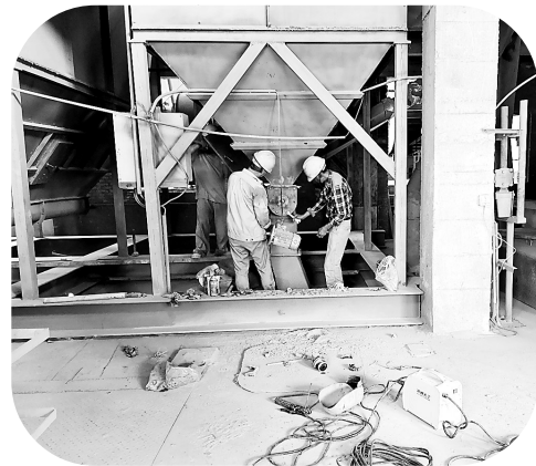
图为抢修现场
