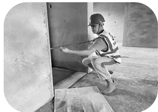
图为徐宗鹭在施工现场进行尺寸复核
