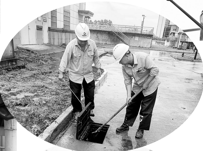
9月5日，三川风电公司组织设备部、运行部人员对设备运行情况进行检查，对登陆段电缆沟进行排水清理，全力保障台风期间公司安全稳定运行、电力供应可靠。图为该公司员工正在清理石城登陆段电缆沟排水渠。 (钱超凡 郑珍贵 摄)
