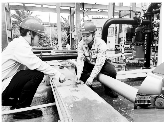
9月5日，台风“海葵”来临，晋南热电公司设备部对户外设备进行全面排查，对露天电气箱进行防雨防风布置，绑扎加固电缆盖板，做好应对强风强降雨应对措施。 (陈嘉楠 摄)
