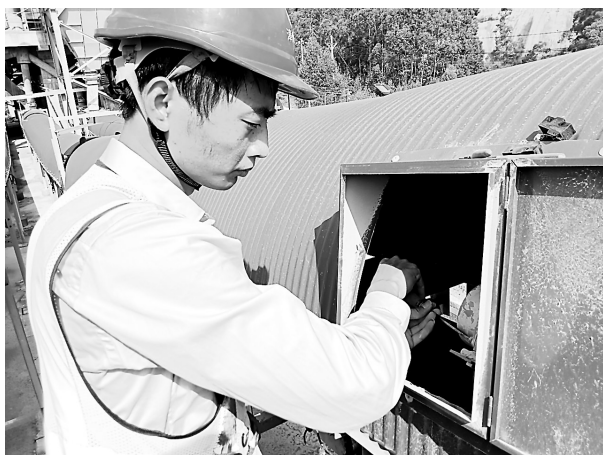
▲永安煤业公司西洋筛选厂利用电力错峰就谷设备停机间隙,对电机设备进行全面检修维护,确保设备安全运行,助力秋季安全生产。图为近日,该厂电焊工对震动筛底座焊接加固。
