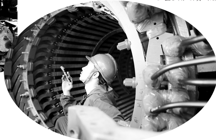
入夏以来,福能贵电公司检修人员不惧高温,坚守在岗位上,保证设备平稳运行。图为近日,该公司检修人员正在对发电机内部进行检查。(张朝贵 摄)
