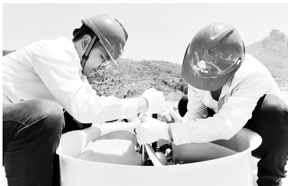
图为抢修现场
