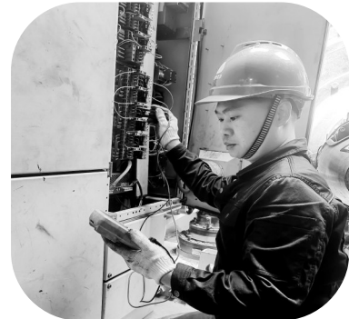
图为李新富在检查风机偏航组合电器 业出一份力，我觉得没有什么比这更值得了！”
