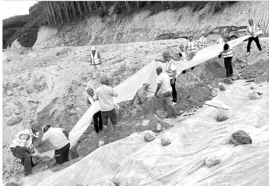
图为该公司人员正在进行边坡苫盖
