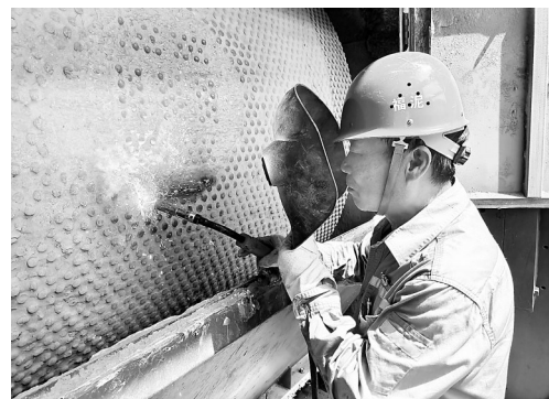
图为陈苏平正在焊接辊面
