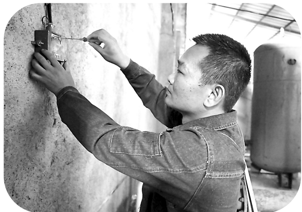
图为林永星在空压机房调校高精度数显温控开关精确数值
