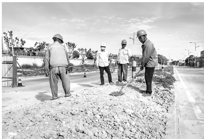
图为热网工作人员现场监督管道回填后路面恢复工作
