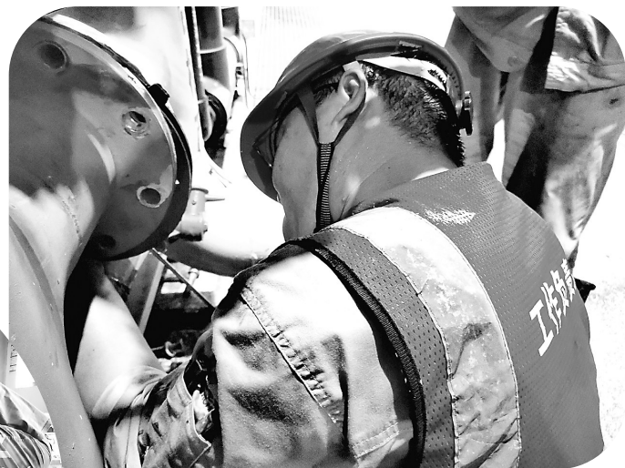
7月5日，晋南热电公司设备部汽机专业检修人员冒着30多摄氏度的高温，连续苦战两个小时，为化水系统的2号RO产水管道更换防爆膜。（周国利 摄）
