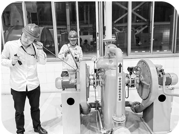
◀ 连日来,鸿山热电公司设备维护部开展用电晚高峰夜间特巡工作,根据夏季高温高湿的特点,针对性地加强设备运行状态检查,重点对转动机械的振动、温度及冷却介质进行检测,及时发现设备异常运行情况,全力以赴保障机组供电、供热安全。(谢涛 摄)
