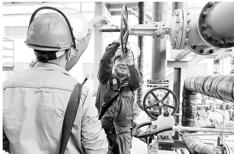
图为操作工李侃正在开循环水阀门
