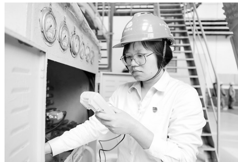
图为汤倩在进行#1炉D磨煤机液压站油温测点检查
